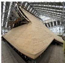
文化財建造物の修理の様子 (県指定文化財方法等本室)
